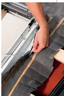
Alátétfólia vízelvezető csatornával
